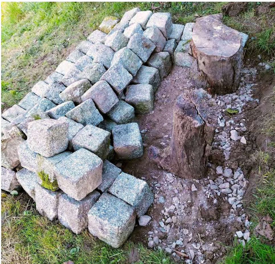
Abb. 6: ostlicher Sand-Stein-Holz-Haufen im Bau mit eingegrabenen Baumstubben
